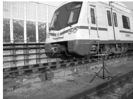
图 16 SJTU-2 型动力吸振多层约束阻尼钢轨现场照片
