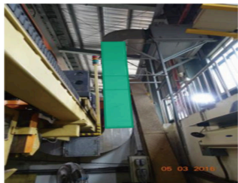
(b) 管道隔声包覆+管道内壁贴 25 mm 玻璃棉
