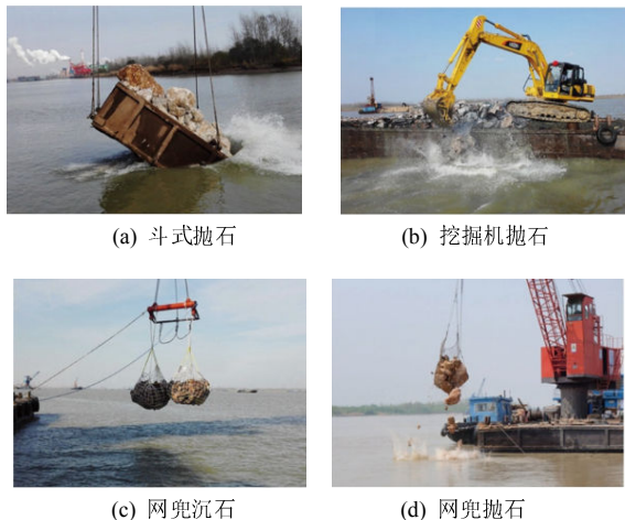
图 2 四种抛石施工图
