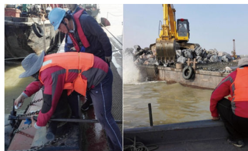
图 3 采集抛石施工噪声现场
